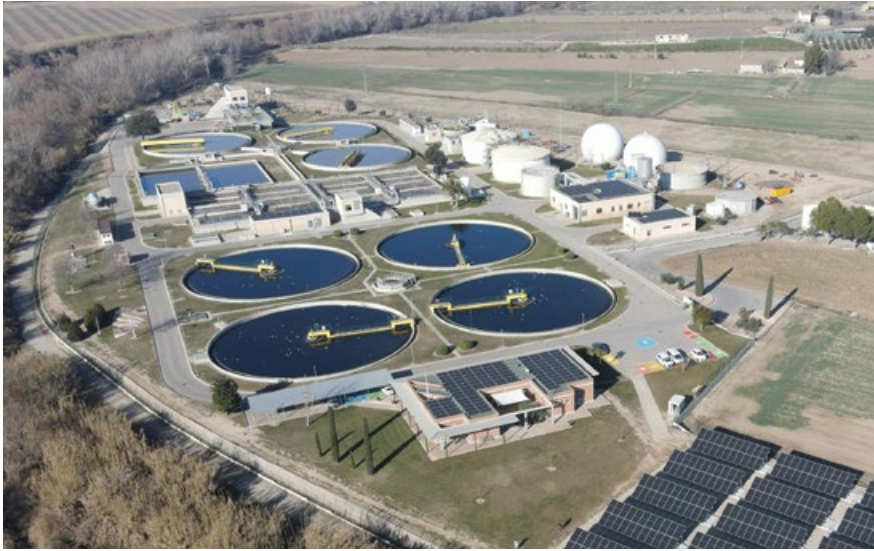
Vista aérea de la depuradora de Lleida.
